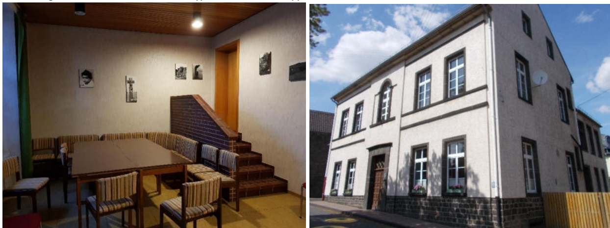
Abbildung 23: Alte Schule von innen (l) und von außen (r)
