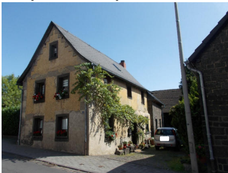
Abbildung 24: Gebäude in der Burgstraße 7
