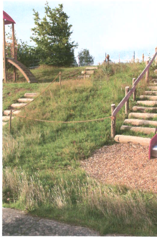
Die neuen Aufgänge und Treppen, sowie die Durchlaufsperrn aus den abgelegten Seilen des Seilpfades
